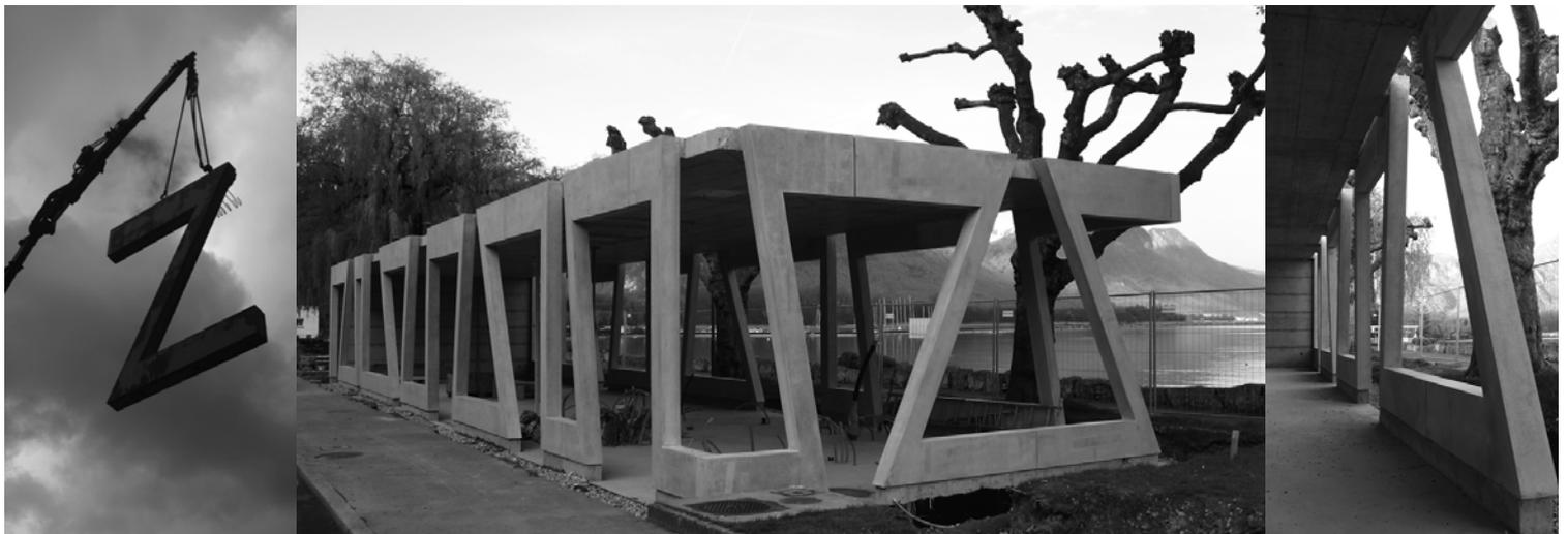
La mise en oeuvre des éléments Z, en béton préfabriqué
