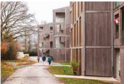
6 Bonhôte Zapata Architectes SA et la Coopérative de l'habitat associatif (CODHA) Habitation et crèche, Rigaud 55, Genève (GE), 2015–2017 Insertion maîtrisée de 49 logements coopératifs entre un secteur de villas et un lotissement de petits immeubles locatifs. En créant six grandes maisons de bois dotées d'espaces et de locaux communautaires, le projet concrétise une certaine idée de la vie en coopérative. (© Johannes Marburg)
