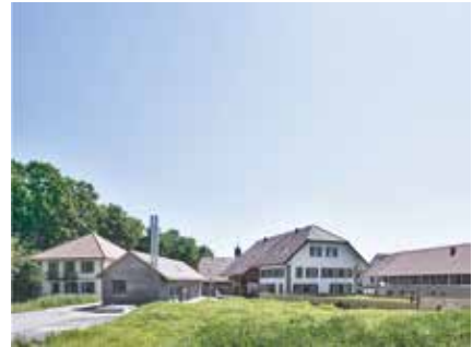
1 LVPH et la Commune de Cressier Intervention dans l'ensemble villageois de Cressier (FR), 2015–2017 En travaillant étroitement avec les habitants, les architectes sont parvenus à insérer de nouveaux éléments tout en requalifiant le contexte bâti. (© Rolf Siegenthaler)
