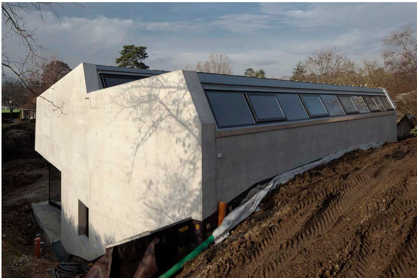
vue depuis l'angle nord - est
